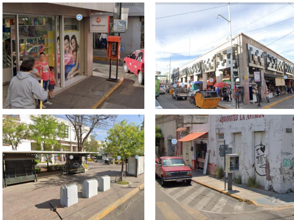
Figura 31 Mobiliario para servicios de comunicaciones y seguridad pública existente y su estado actual en la ZUFO Centro.
