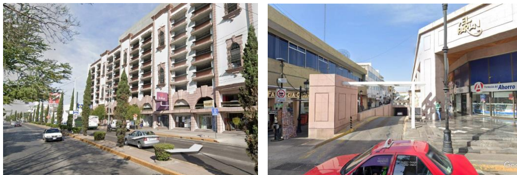
Figura 53 Estacionamientos públicos de pago de varios niveles
