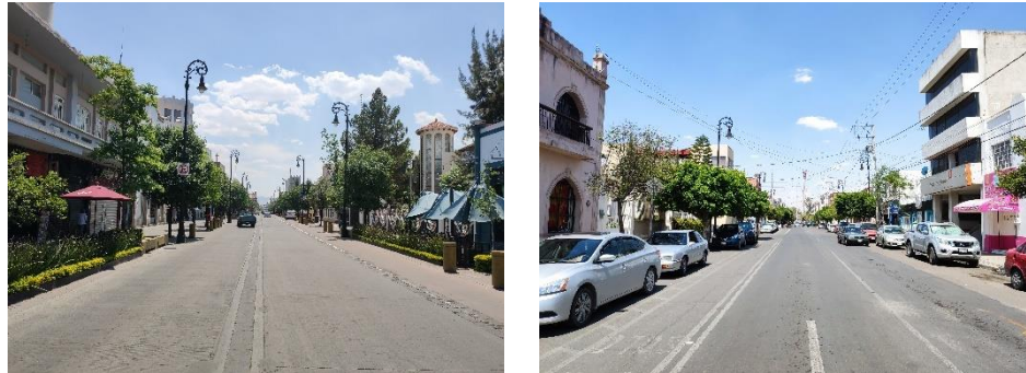
Figura 14 Calle intervenida con vegetación arbórea.
