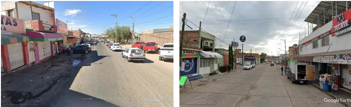
Áreas deficientes de carga y descarga y falta de estacionamiento en Boulevard Guadalupano y Calle Refugio Miranda Aguayo. Foto: IMPLAN, 2023.
